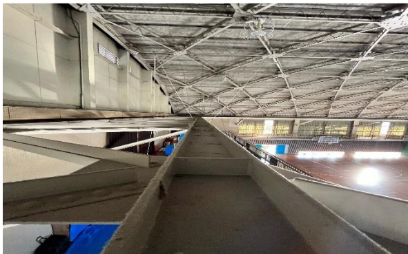
図2 耐震補強に用られているH鋼
