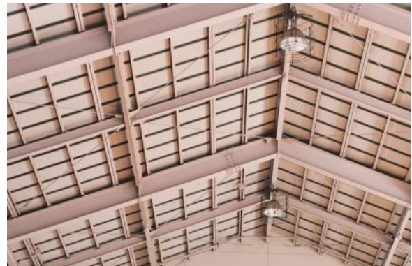
図3 体育館天井の支柱
