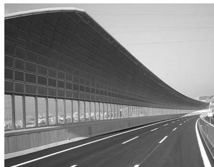
図1 高速道路の防音壁
