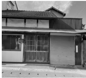
図7 ⑥瓦屋根の建物
