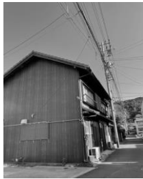
図6 ⑤瓦屋根の建物
