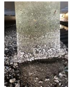
図7 橋の下に密集しているカキの様子
