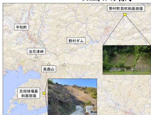
図 5 斜面崩壊位置とその様子
