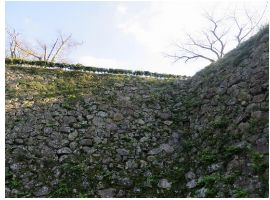
図4 階段から石垣を見上げた写真
