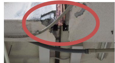
写真1. 外壁のひび割れ
