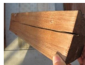
写真4 乾燥による木材の割れ
