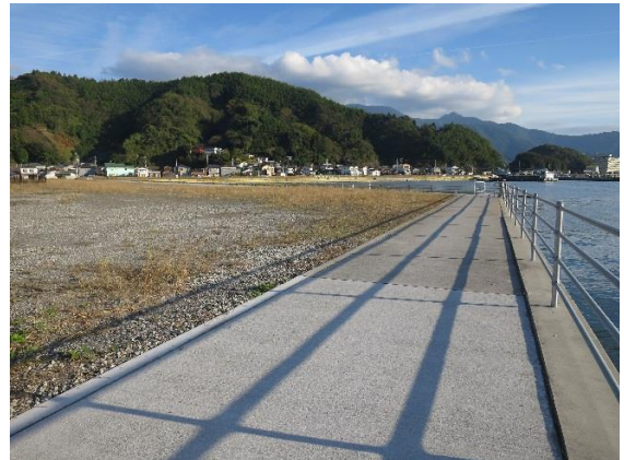
写真1 大浦海岸の埋立地の様子
