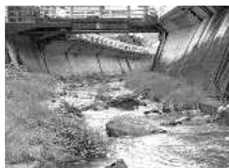
写真2 神田川(上流) 川幅が狭い
